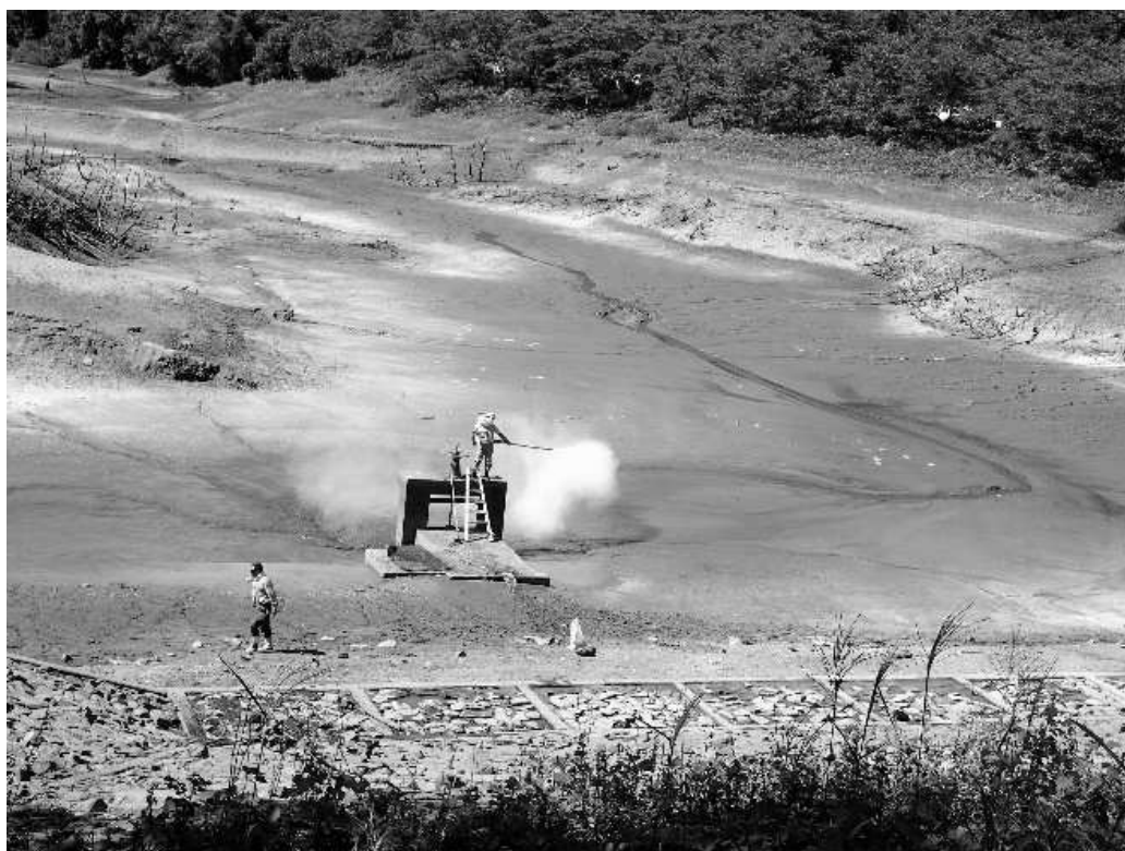
図 15. 宮城県栗原市照越ため池での池干し（斉藤ほか 2021）。底樋を抜いて、水の通り道をつけて、さらには念のため石灰をまいている。
