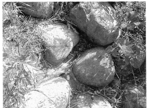
図12. カヌー競技場より上流区間に設置された石垣のフェイク. 中央に樹脂製織布の一部が見える。
