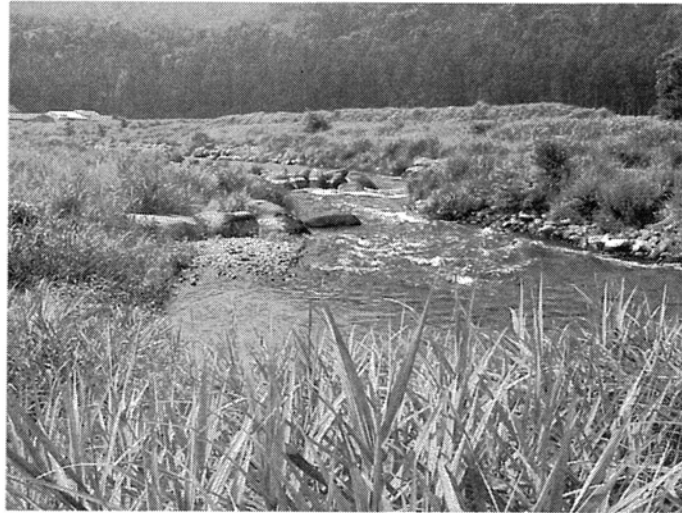
図8. 右曲がりの屈曲(その先は左に曲がっている)の外側にだけ石が置かれた構造。
